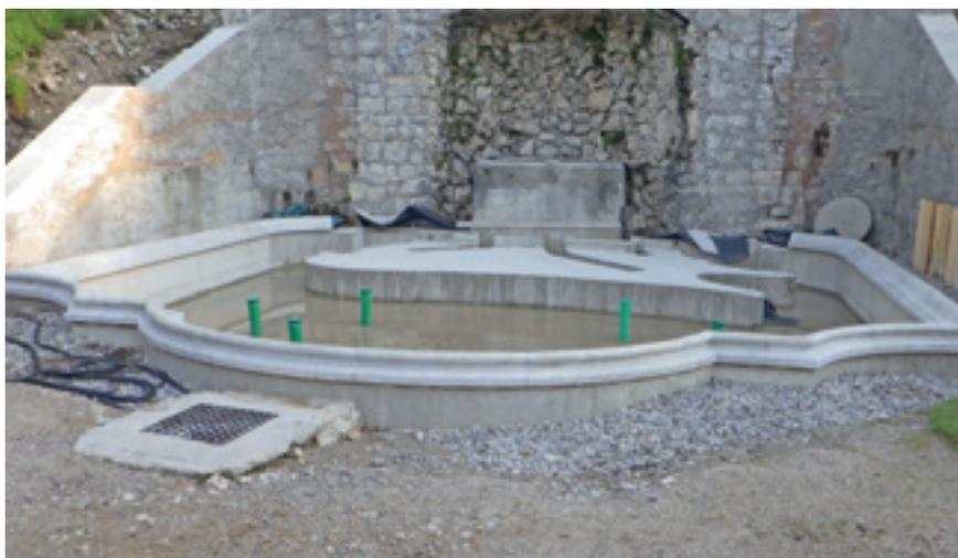
**Unterkonstruktion Neptunbrunnen mit Profilsteinen für Wasserfassung**
