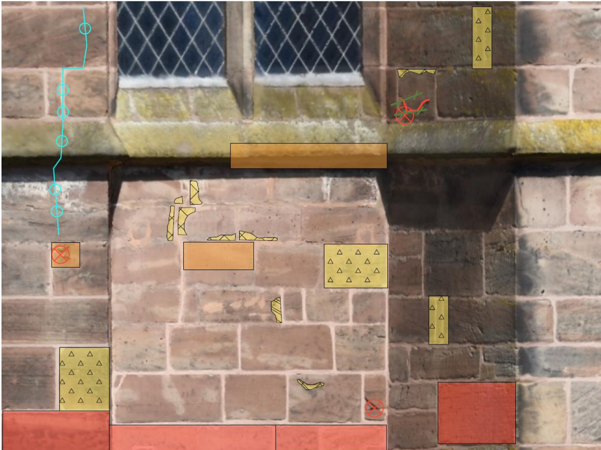
Bild: Ausschnitt Maßnahmenplanung Sandsteinfassade
