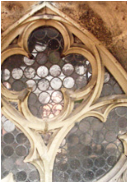
Die Steinmetzwerkstatt Kling hat die Maßwerkfenster im Joch 5/20 konservatorisch restauriert, hier Joch 20, Vor- und Endzustand. Unter Berücksichtigung der Vorgabe, die Originalsubstanz maximal zu erhalten, arbeiteten Ulrich Kling und sein Team bei großen Schadensbereichen halbe Neuteile nach historischem Vorbild, die sie auf die intakte Konstruktion aufdoppelten und verankerten. Hierfür erhält er bei der Peter Parler-Preisverleihung eine Belobigung. Bilder: Firma
