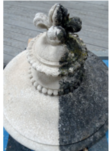
Musterfläche für Reinigung der Steinoberfläche an den Vasen vorher/nachher.
