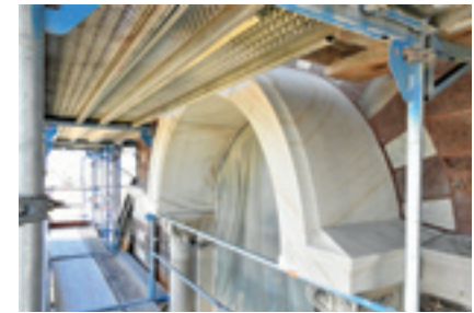
Vorzustand und Endzustand der bogenförmigen Verdachung
