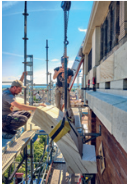
Einsetzen von Neu- und Altteilen an der Balustrade
