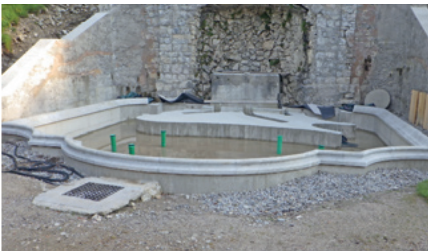
Unterkonstruktion Neptunbrunnen mit Profilsteinen für Wasserfassung
