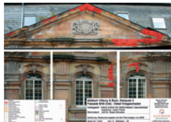
Die Firma Glöckner Natursteine ist seit vielen Jahren mit der Restaurierung der Fassaden der Alten Abtei in Mettlach beschäftigt. Der Wettbewerbsteil umfasst das Gebäude 3 (BA9) der Ostseite der Abtei.
