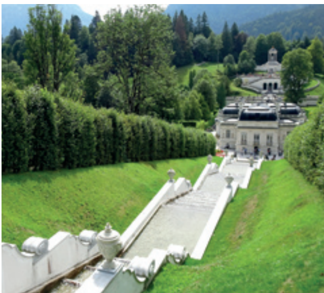
Kaskade mit Wassertreppe von oben mit Blick auf das Schlossgebäude Fotos: Firma Bauer-Bornemann
