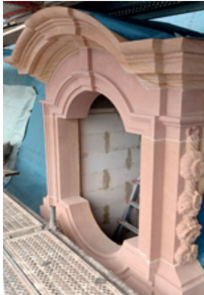
Nach historischen Plänen rekonstruierte, neue Dachgaube
