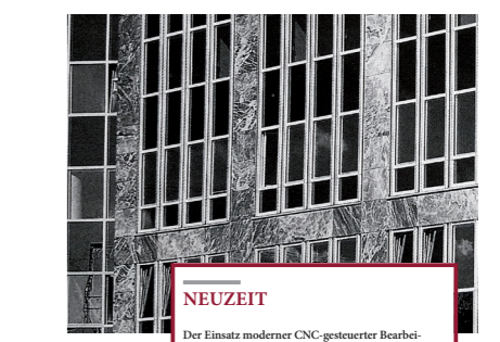
Büro- und Geschäftsbau „Celtishaus“ in Nürnberg. Die Stahlbetonsäulen und Horizontalfläse sind mit einem brasilianischen Mignatt bekleidet.
