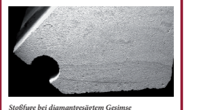
Stofflage bei diamantgesägtem Geseis (nicht fuggerecht)
